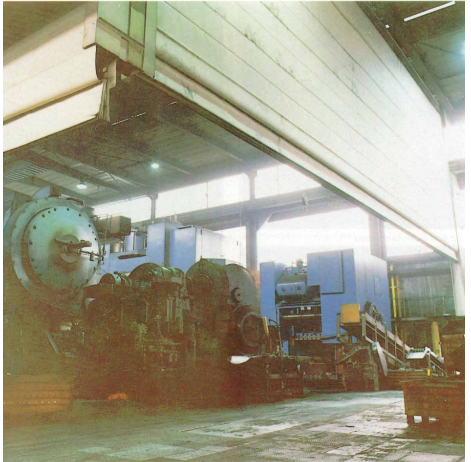
Großtrennwände beeinträchtigen den Arbeitsablauf nicht
