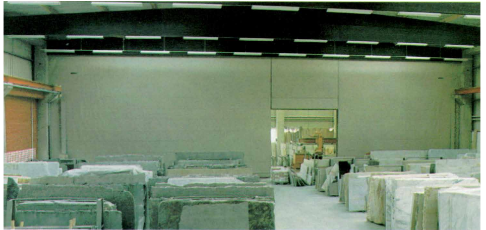
Großtrennwand 3teilig mit Durchfahrtöffnung
