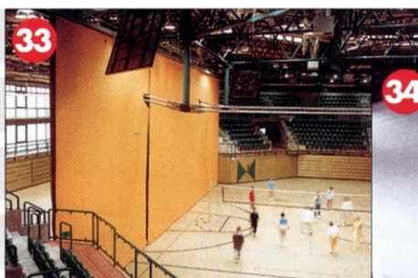
33 Trenomat Trennvorhänge. Durch das anpassungsfähige Variantsystem lassen sich die Trennvorhänge nicht nur in Neubauten montieren, sondern auch in bestehenden Sport- und Mehrzweckhallen nachrüsten.
