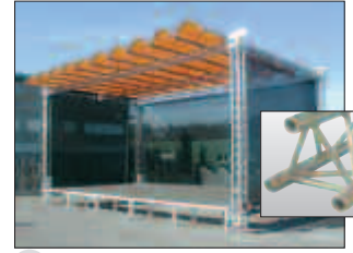
8 Open-Air Dachkonstruktionen und Traversen
